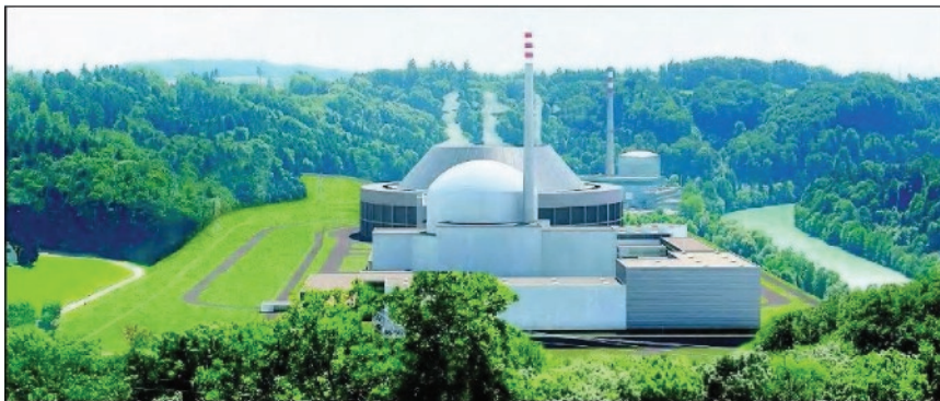
Für Projekte wie das neue AKW Mühleberg braucht es mehr Personal. (BKW)
